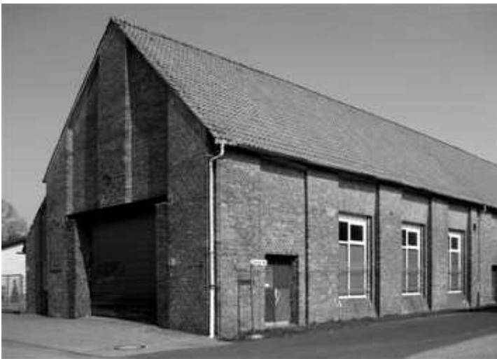
tungen zu den Luftschiffhallen geleitet, wo die Luftschiffe damit befüllt wurden. Von diesem Gaswerk steht heute nur noch die Kompressorenhalle, in der der erzeugte Wasserstoff mit 3 Kompressoren auf 100 bar verdichtet und in 180 unterirdische Hochdrucktanks gepumpt wurde.
